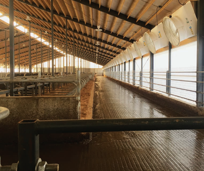
Le Dr Jones dispose un ventilateur d'un mètre de diamètre à tous les trois mètres.
